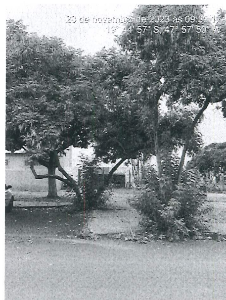
Figura 3: Rampa e passagem comprometidas. Fonte: SEMAM, 2023.
